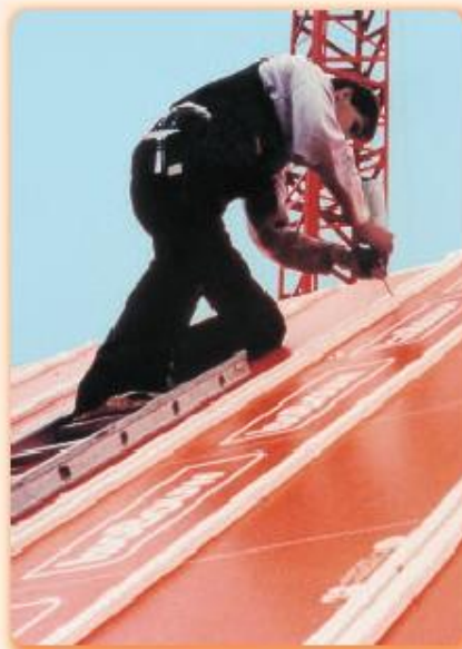
Zapěňování podélných spár
